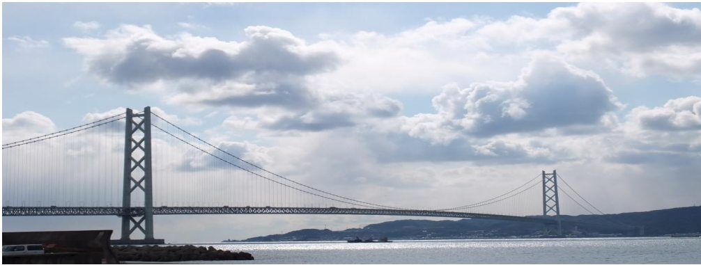
【図15】 明石海峡大橋
