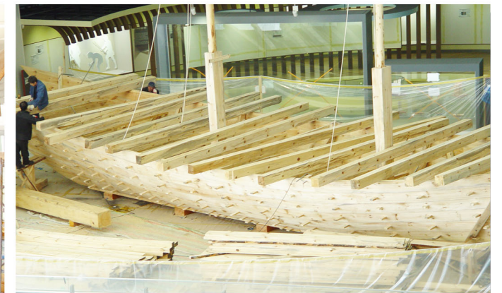
4. 외판 및 가목 설치
